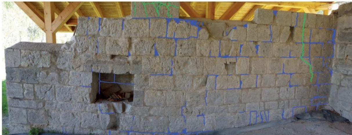
Ico 2022- Élévation Sud du mur Nord du Chœur. Projet : En bleu proposition de contournement partiel et localise des joints et en vert les obturations /injections proposées dans les pierres taillées.
